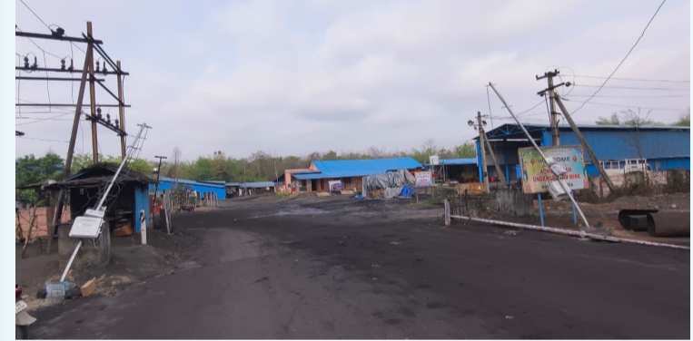
ముణుగూరు, ఏప్రిల్ 16(మీడియా టుడే):
